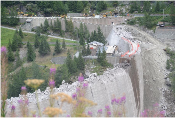
Figure 14. A sequence of the dam demolition: cleaning and smoothing of the crest surface for further working phases / Sequenza dei lavori di demolizione: sistemazione della superficie del coronamento per le fasi successive.
