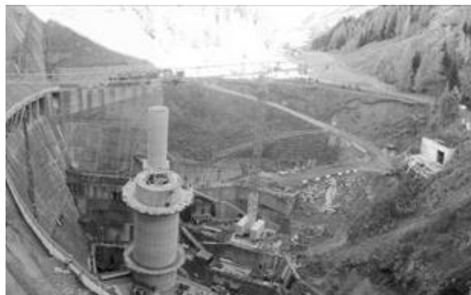
Figure 12. New structures at the downstream toe of the dam and inspection shafts / Alcune delle nuove strutture poste a valle della diga e pozzi di ispezione.
