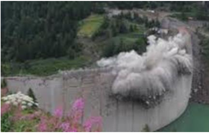
Figure 13. A sequence of the dam demolition: blasting phase / Sequenza della demolizione con esplosivo
